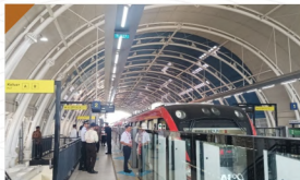
Stasiun LRT Harjamukti
